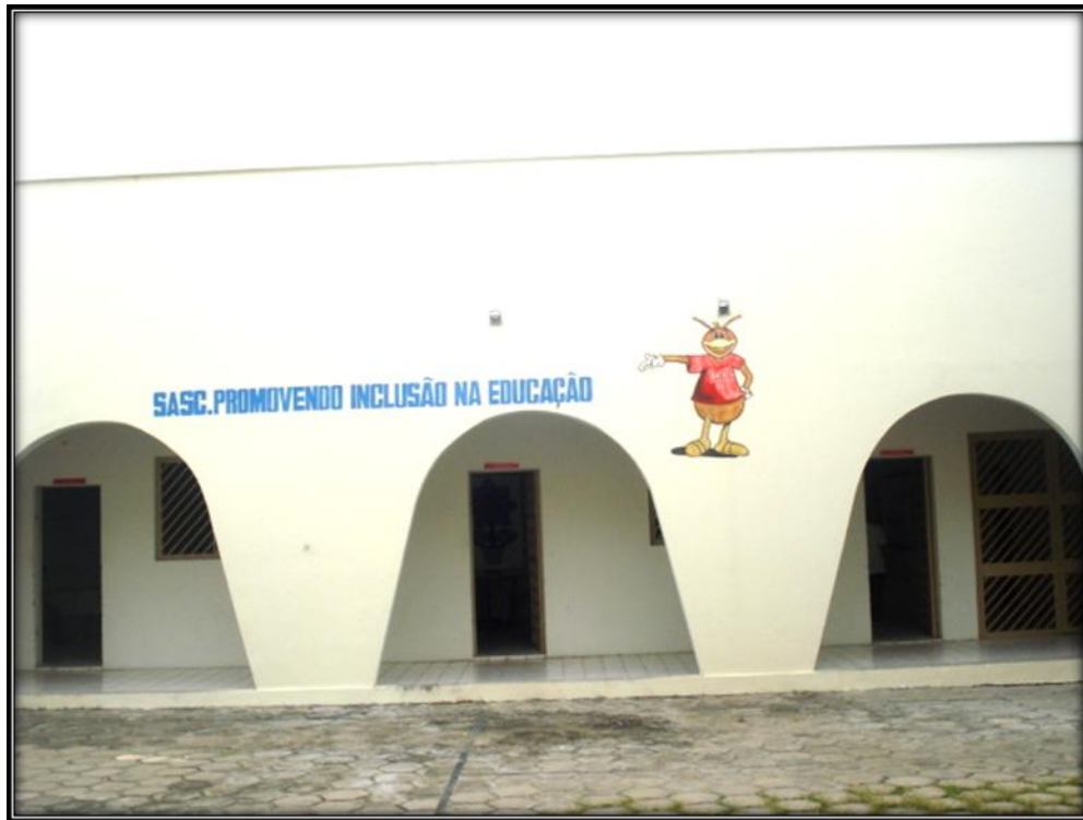
Figura 9- Fachada do anexo escolar
